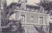
FLEVORAMA - N. RUIJSKADE 1
